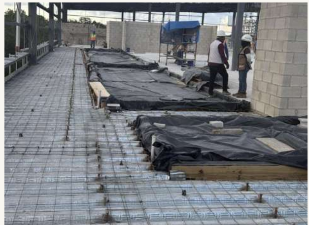
06 • Cimbrado especializado en áreas frigoríficas
