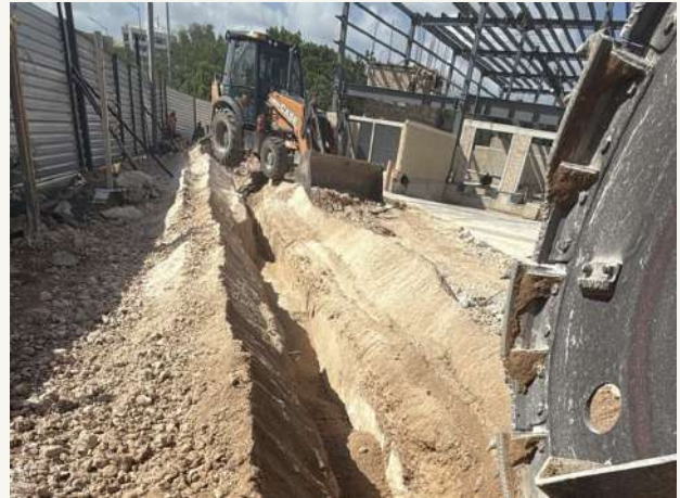
02 • Terracerías y zanjado de alta capacidad
