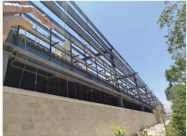
04 • Montaje de estructura metálica y cubiertas
